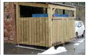
■ Le groupe électrogène avec sa nouvelle protection.
